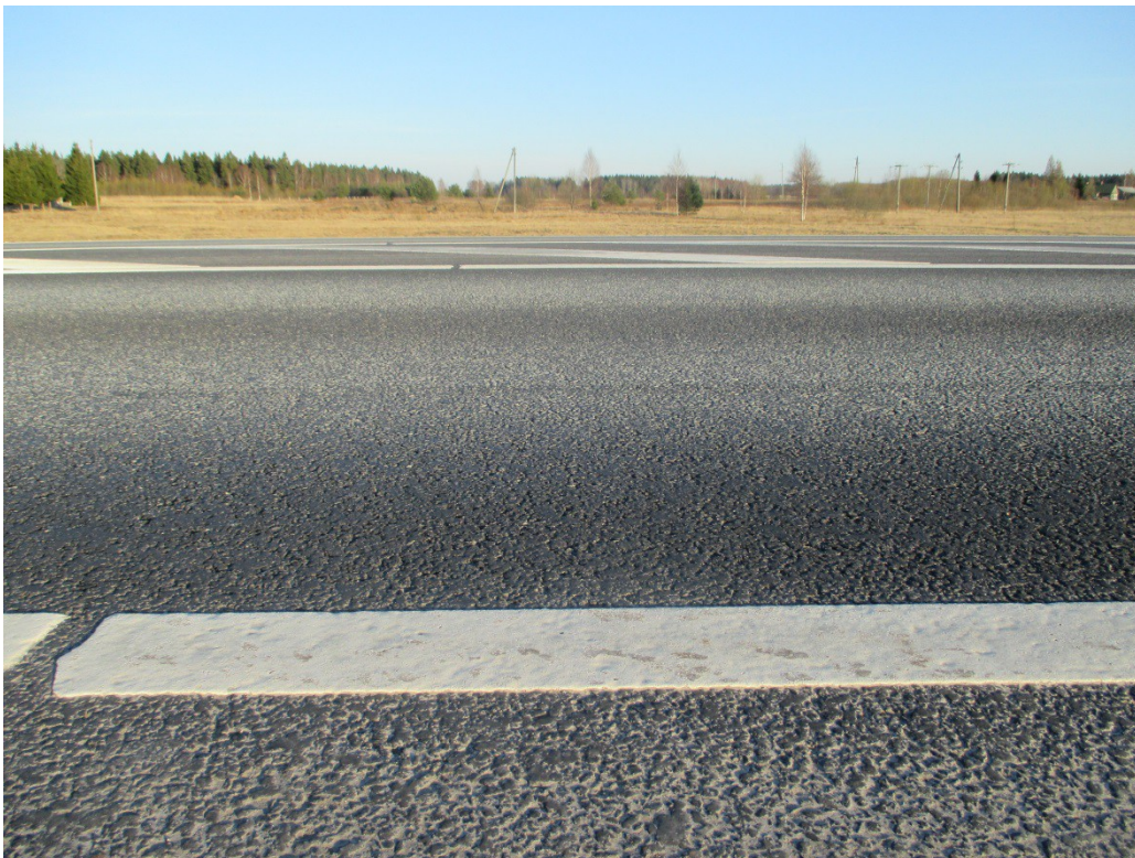
2.52.att. Autoceļa A3 24.km – neliels virsmas nodilums
