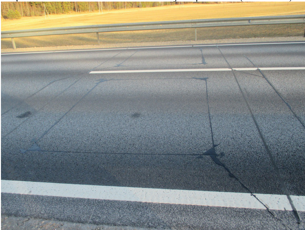
2.8.att. Sensoru izvietojums uz autoceļa A3 24.km
