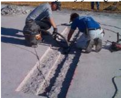
1.15.att. Elastīgās plātnes montāža
