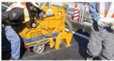
1. Asfalta izfrēzēšana
