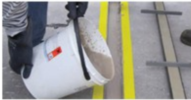
4. Aizpildīšana ar javu
