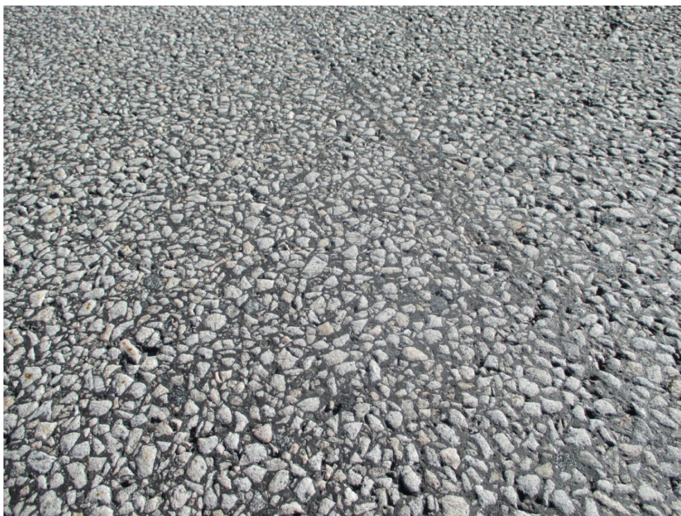
2.48.att. Virsmas nodilums a/c A1 72.km
